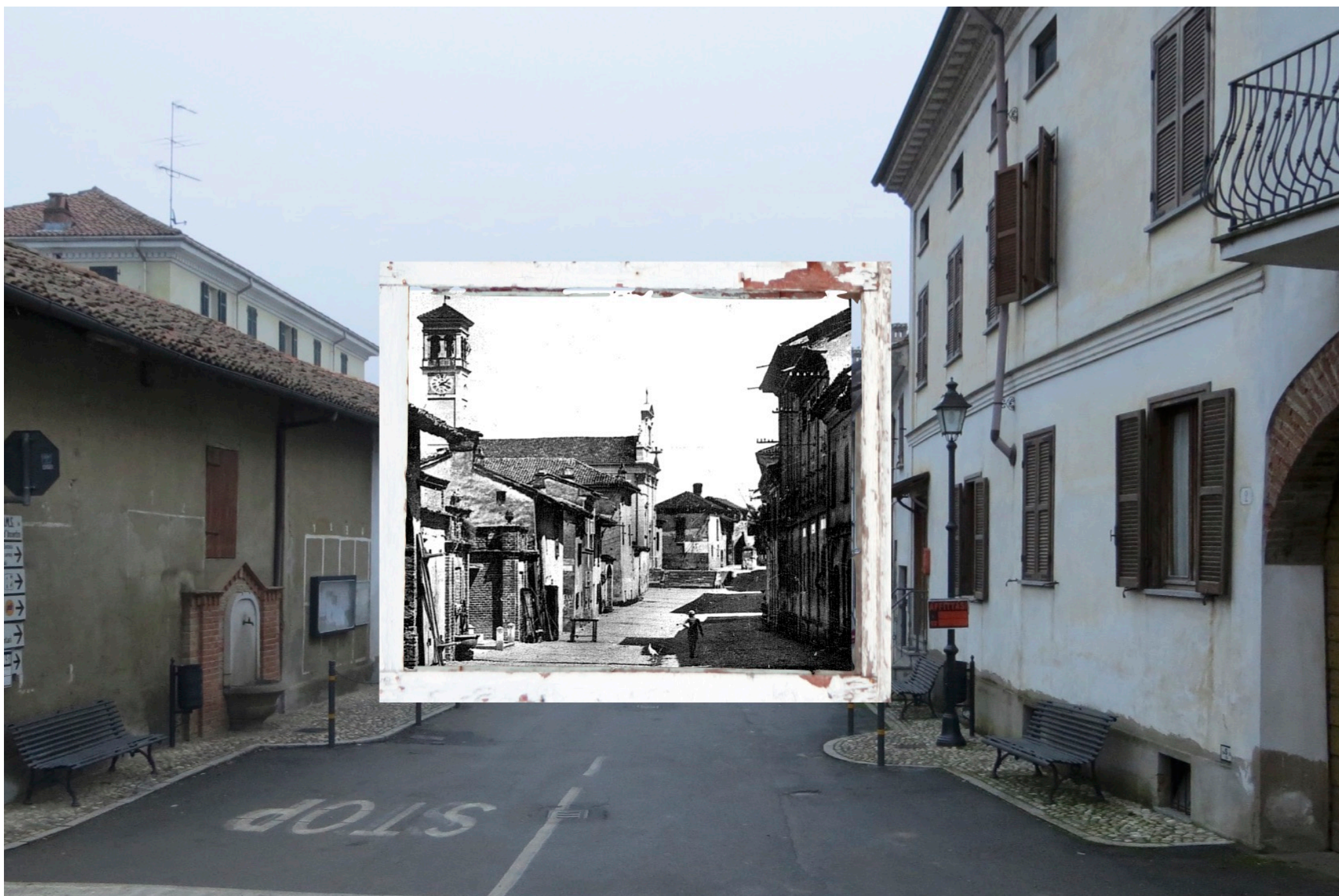
Via Contrada Grande già Via Roma - Panorama
